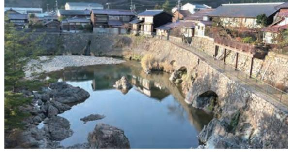
このトロッコ軌道は、生野の町を走っていた馬車鉄道を廃止して、大正9(1920)年に電車軌道として完成しました。市川にアーチ型の石垣を積んで、川に張り出して線路が確保されており、今もその美しい姿を見ることができます。当時は、生野鉱山本部から生野旧駅までの間を、アメリカ製の6トン電気機関車が500mm軌道で結んでいました。現在、軌道の残る遊歩道として整備されています。
